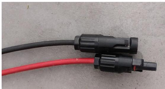
Figura 18 - Cavi in derivazione dal quadro di stringa intestati con connettori MC4
