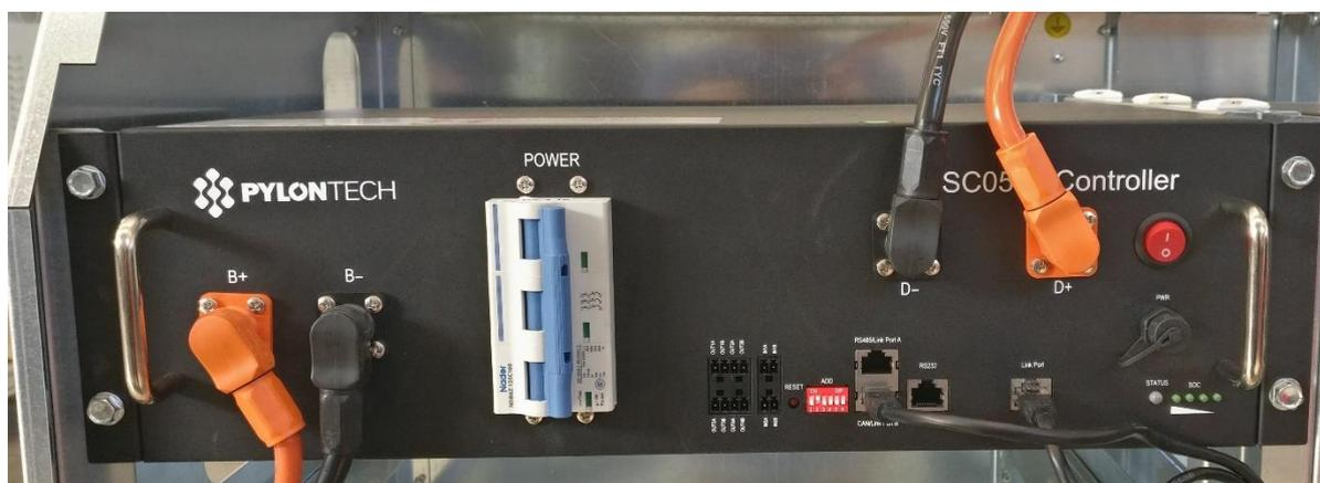
Figura 111 - Unità di gestione delle batterie denominata “SC500A-100S” BMS n.2 (BMS2B)
