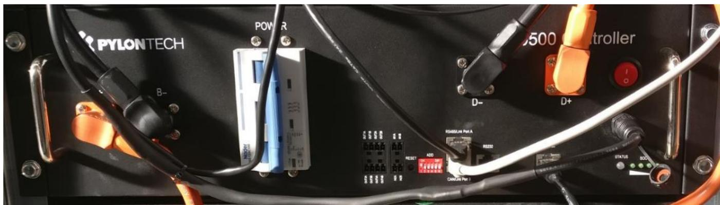
Figura 117 - Settaggio del selettore a DIP-SWITCH denominato “ADD” presente sull’unità di gestione delle batterie denominata “SC500A-100S” installata sul telaio del RA STORE 3
