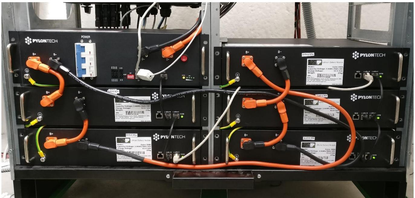
Figura 10 - Connessioni moduli batteria e modulo BMS
