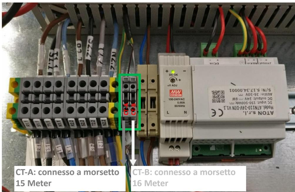
Figura 16 - Morsetti di collegamento al Meter
