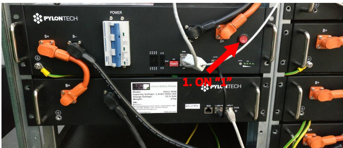
Figura 125 - Interruttore "0/1" BMS "SC500A-100S batterie colore rosso in posizione di "1"
