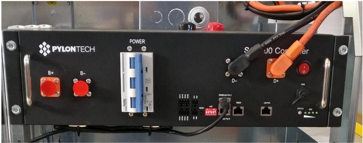
Figura 113 - Unità di gestione delle batterie denominata "SC500A-100S" BMS n.3 (BMS3B)
