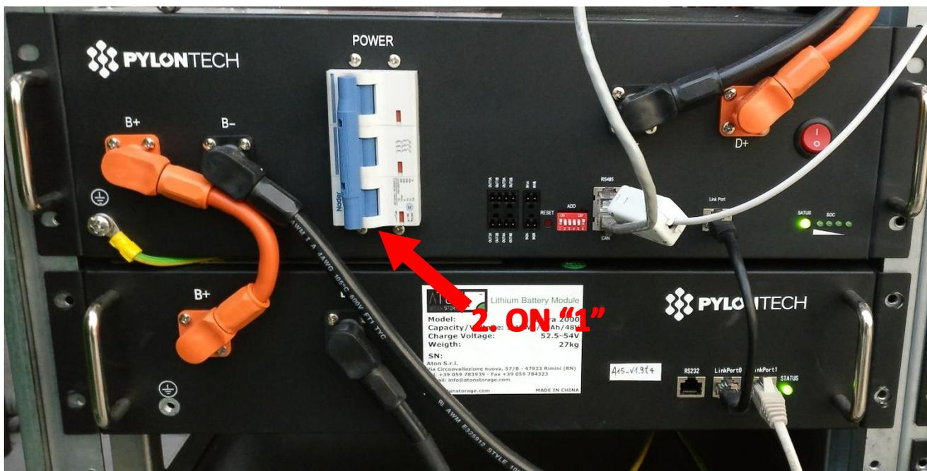
Figura 126 - Magnetotermico BMS "SC500A-100S batterie ON (indicatore stato rosso)
