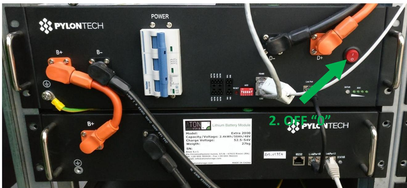
Figura 124 - Interruttore "0/1" BMS "SC500A-100S" batterie colore rosso in posizione di "0"
